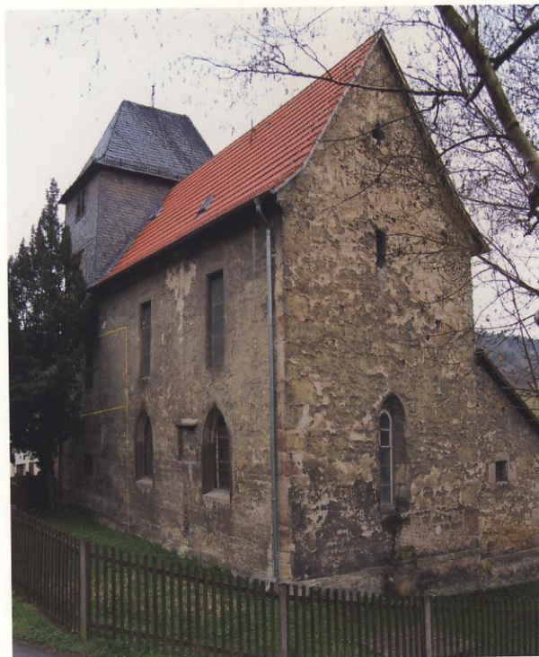
Abb. 1 Blick von Südosten, 2012. Der hohe schmale Baukörper der Kirche wird im Westen vom verschiefernten Turmaufsatz überragt; der Chornordseite ist die Sakristei angefügt. Gelb markiert sind im westlichen Teil die einstigen Traufhöhen von Bau I und Bau II.
